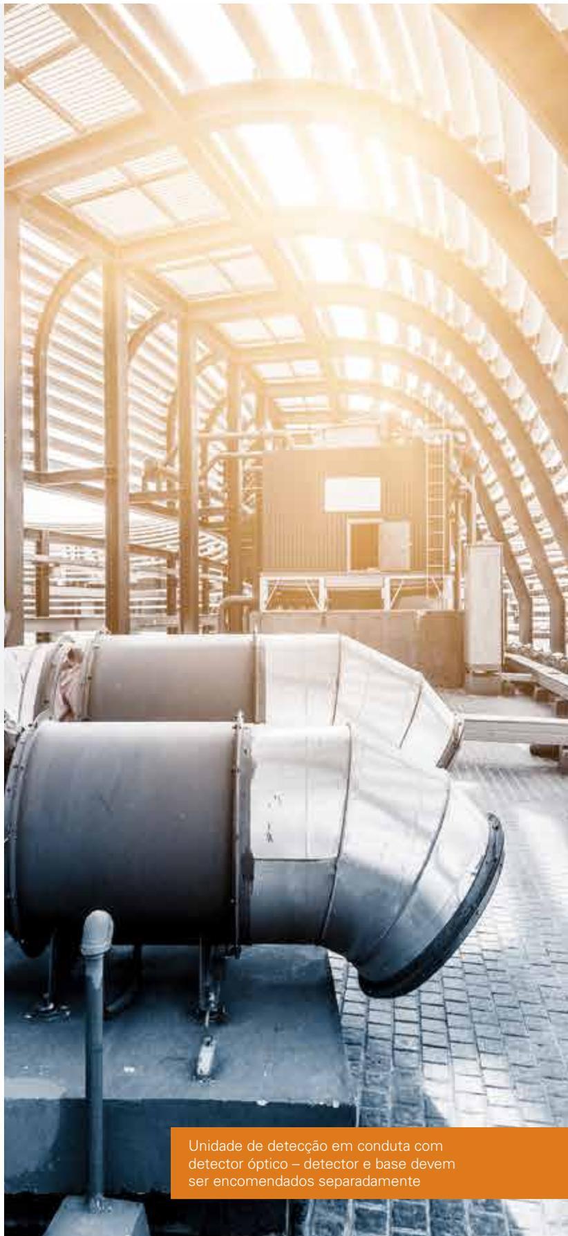
Unidade de detecção em conduta com detector óptico – detector e base devem ser encomendados separadamente
