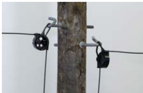
Baixada de cabos de fibra com mordente para cabo FTTH.
