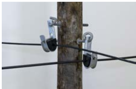
Suporte tangencial de cabos de fibra com pinça de suspensão.
