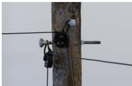
Baixada de cabos de fibra com mordente para cabo FTTH.
