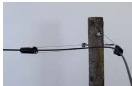
Suporte a 90° de cabo de fibra com pinça de amarração para ADSS.
